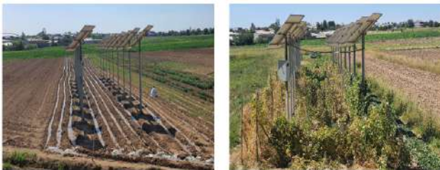
Figure 1. O‘zbekistonda birinchi quvvat 10 kW teng bo‘lgan agrovoltaika tizimi
